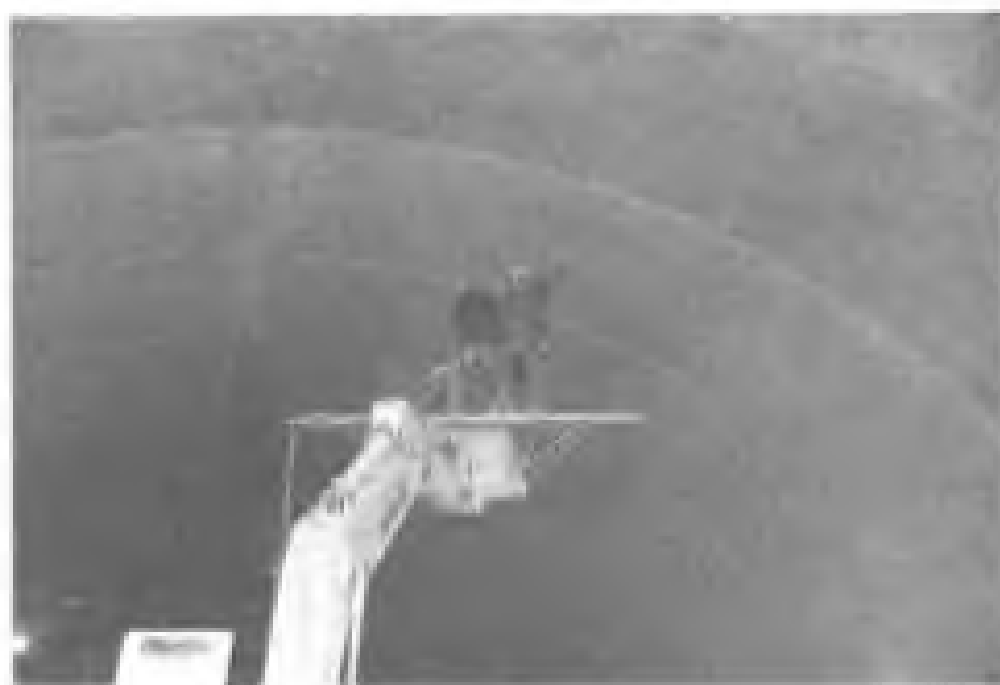
图 2.17 隧道衬砌钻孔确定混凝土厚度
