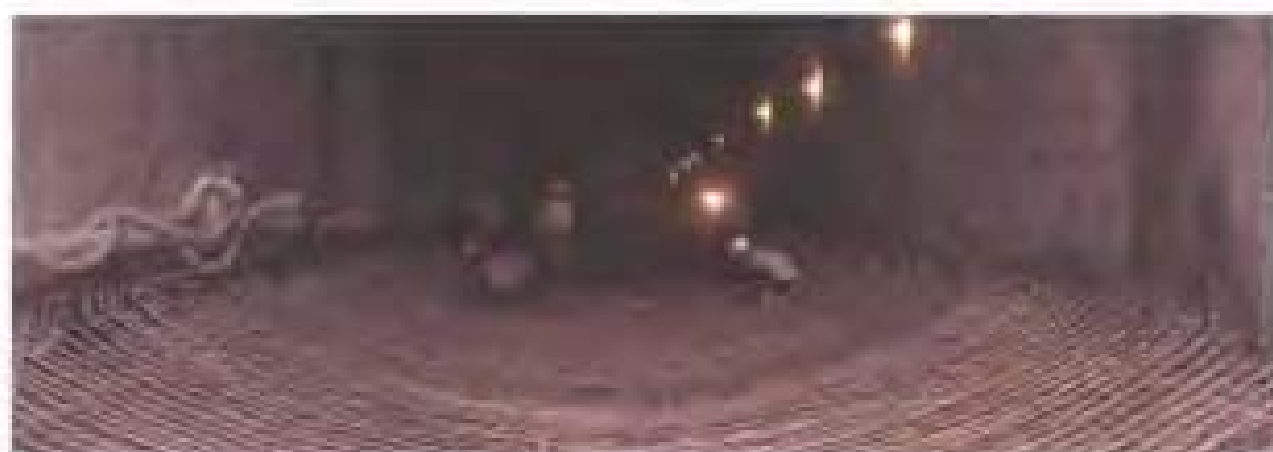
图 6.26 基底铺设钢筋
