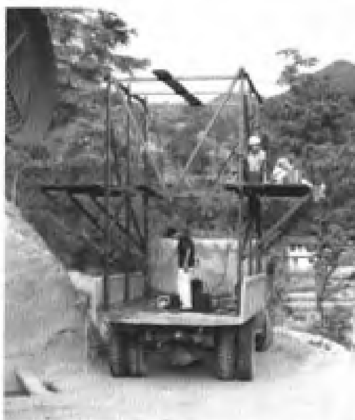
图 5.2 新建隧道搭建简易检测台车
