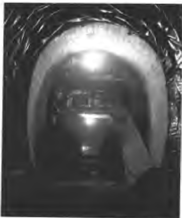
图 4.4 拼装模板台车
