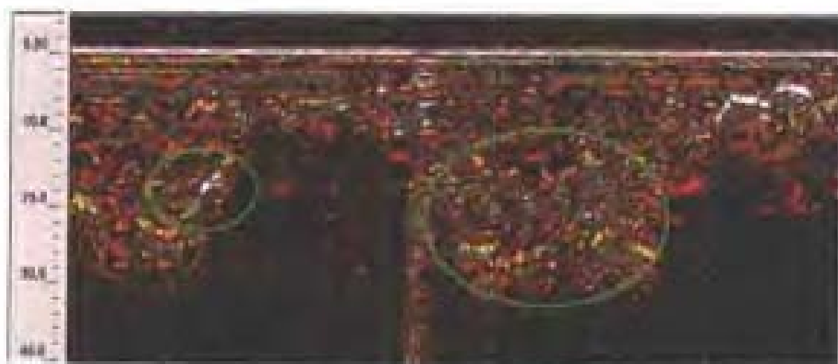
图 6.10 塌方回填片石，局部存在空隙
