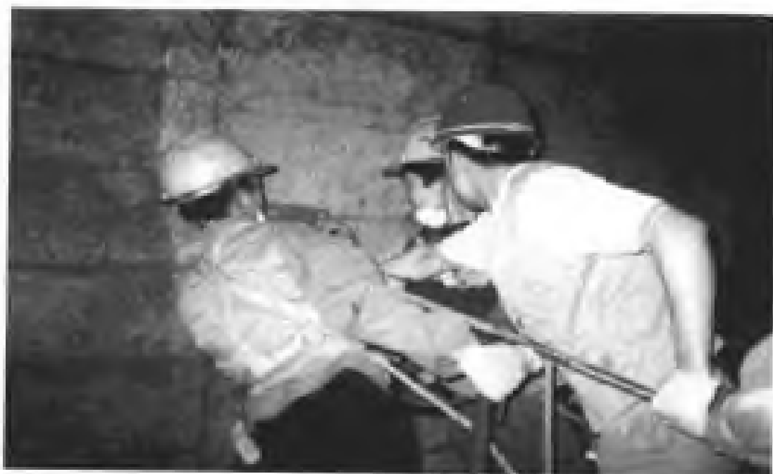
图 5.4 检测隧道拱腰部位
